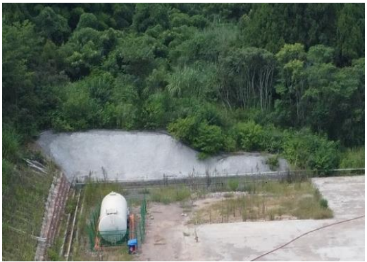
挡墙及排水沟
